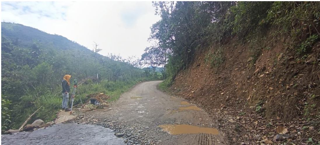
Imagen 2. Estado actual de la vía
