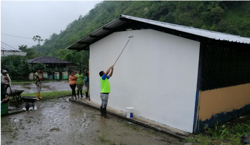
figura 1: Pared a intervenir de la escuela en Loyola. Fuente: Equipo técnico GADP-El Porvenir del Carmen.
