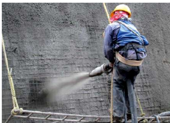
Foto 65. Protección de taludes con maya electro soldada y hormigón proyectado
