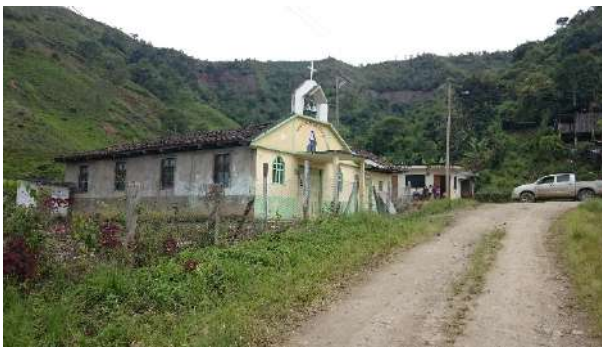
Foto 32 Vista vivienda barrio Santa Clara
