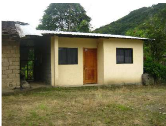
Foto 42: Vivienda en buen estado (Barrio Santa Clara)
