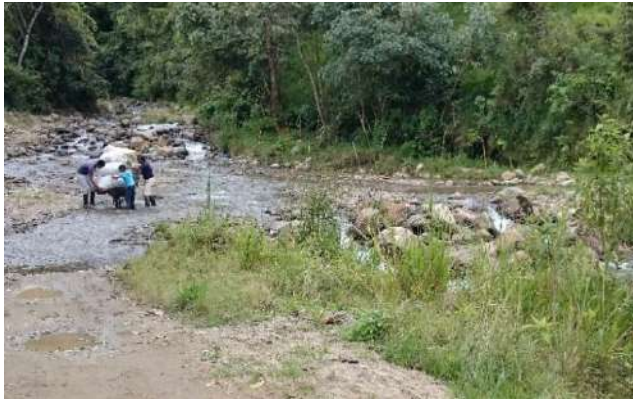
Foto 56: Via de entrada a Cumandá donde no existe un puente sobre quebrada.
