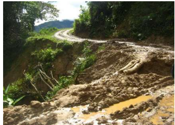
Foto 58: Vial de entrada a Las Orquídeas en paupérrimas condiciones.
