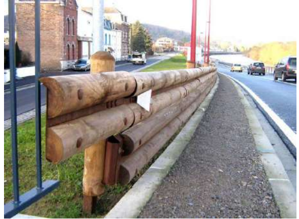
Foto 61: Valla de protección en madera Fuente: Archivo personal equipo consultor 2015
