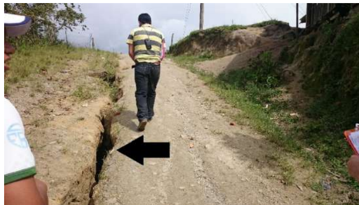
Foto 55: Zanja al aire libre por la que circulan las aguas negras de las viviendas al no poseer alcantarillado sanitario ni pluvial (barrio El Panecillo)
