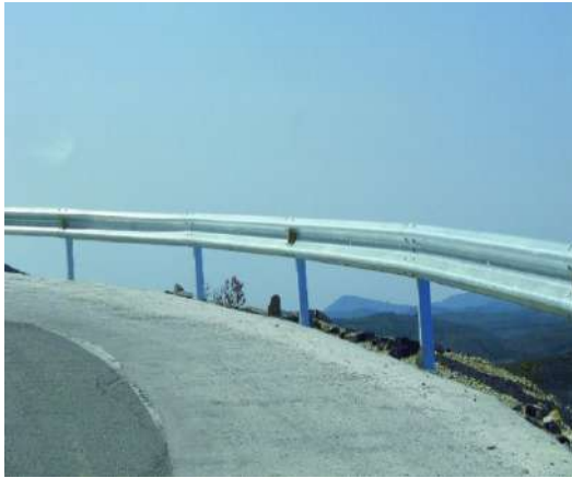
Foto 62: Valla de protección en metal Fuente: Archivo personal equipo consultor 2015
