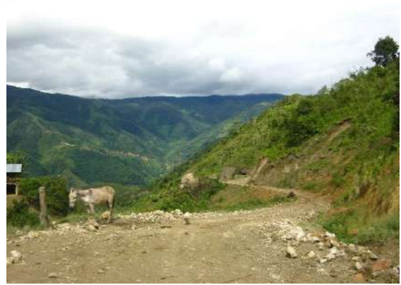
Foto 57: Vial al Panecillo en pésimo estado
