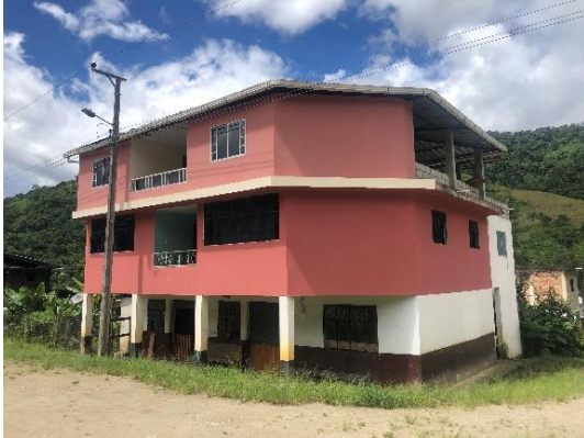
Foto 24: Vivienda de hormigón
