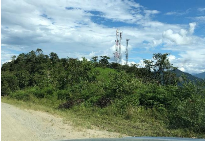
Foto 52: antenas repetidoras para servicio del Cantón Palanda
