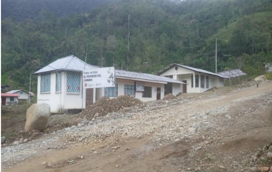
Foto 2: Puesto de salud el Porvenir
